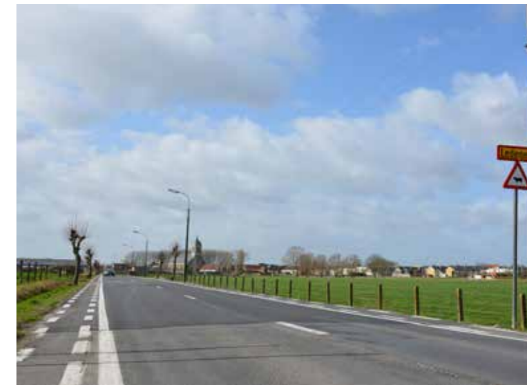
Smal aanliggend fietspad met voorbij gierende auto's is niet het gewenste cadeau voor fietsers.
