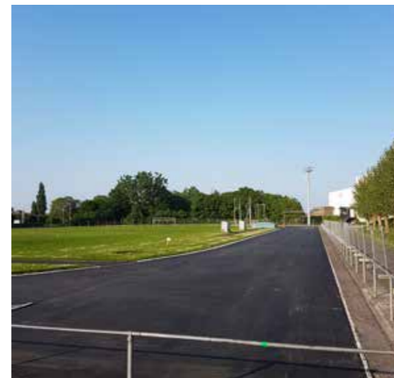
De nieuwe onderlaag, voor de plaatsing van de nieuwe rode toplaag.
